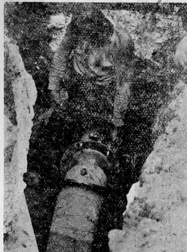
連絡鋼管接合作業
