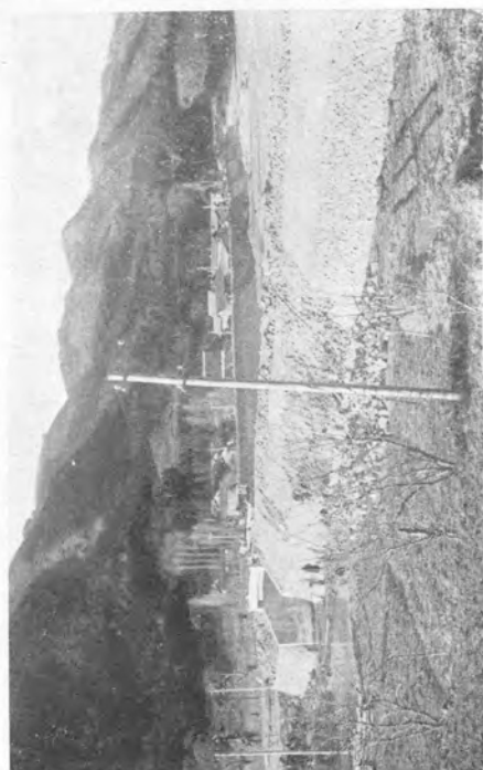
2. 宮城縣大原村谷川。 復興状況。海岸に防浪堤を築造す。部落後方(寫眞の右方)高臺に敷地造成を行ふ。(附圖第 1 圖並計畫圖參照)昭和九年一月末撮影。
