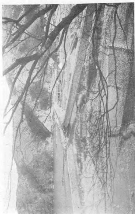
2. 宮城縣大原村谷川。 復興状況。海岸に防浪堤を築造す。部落後方(寫眞の右方)高臺に敷地造成を行ふ。(附圖第 1 圖並計畫圖參照)昭和九年一月末撮影。
