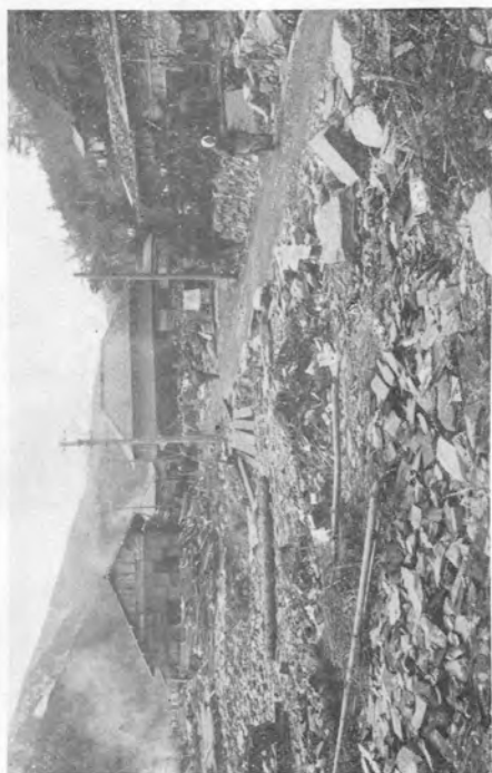
6. 宮城縣十五濱村雄勝。 市街地災害状況。中央に在る縣道と右方山地部とに挟まれたる敷地を約2米地上げし226戸を收容す。(附圖第2圖並計畫圖參照)
