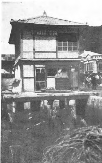
33. 岩手縣釜石町。 災害狀況。海面に突出し鉄筋混凝土床版上に基礎を固定し建築せられたる木骨タイル張り建築の被害。津浪は一階軒下迄達したるも窓其他を破壊せられたるに止る。(昭和八年五月四日撮影)
