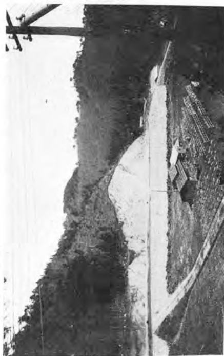
40. 岩手縣鷺住居村兩石。住宅適地造成事業進捗状況。寫眞第 39 圖の延長。以上本部落に於ける造成敷地面積 3,391 坪、收容戸數 93 戸、(附圖第 28 圖並計畫圖參照) 昭和九年三月末撮影。
