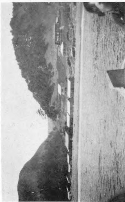
56. 岩手縣田野畑村平井賀。波高10米、(明治二十九年には寫真右方最上位の家屋迄浸水す)流失倒壊戸數50戸、前面高地は移轉敷地の一なり(附圖第38圖並計畫圖參照)昭和八年五月八日撮影
