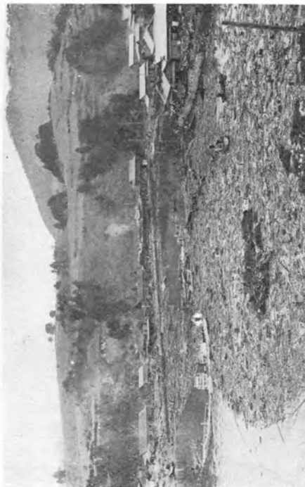
13. 宮城縣唐桑村小罇。災害状況。波高2.70米の津浪に依り流失、倒壊戸数31戸を出す。津浪は寫眞第14右上薬葡屋根家屋の床上に及ぶ。
