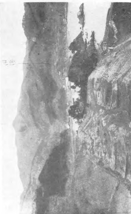
20. 岩手縣綾里村田濱、石濱。田濱、石濱兩部落に於ける住宅適地造成事業進捗状況。灣形申類第二に屬し、津浪波高前者は 7.7 米、後者は 9.0 米、敷地造成面積田濱 989 坪、石濱 1,130 坪。(附圖第 18 圖並計畫圖參照) 昭和九年三月二十三日撮影。
