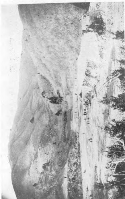
8. 宮城縣大濱村相川。 敷地造成事業進捗状況。2,300坪の敷地を造成し29戸を收容す。(附圖第4圖並計畫圖參照) 昭和九年一月三十一日撮影。
