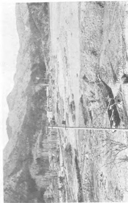
3. 宮城縣大原村大谷川。 災害状況。波高 5.6 米の津浪に依り海岸道路破壊す。
