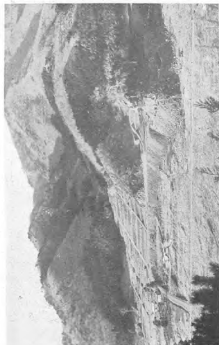
26. 岩手縣唐丹村本郷。住宅適地造成事業進捗状況。寫眞第 25 に示す位置に於て面積 5,637 坪の敷地を造成し 101 戸を收容す。山裾を縫ふは附替縣道。左方の道路は連絡道路(附圖第 26 圖並計畫圖參照)昭和八年三月末撮影
