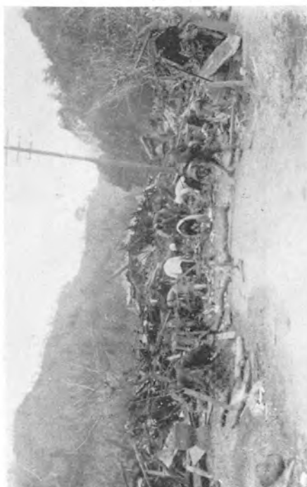
33. 岩手縣釜石町。 災害狀況。海面に突出し鉄筋混凝土床版上に基礎を固定し建築せられたる木骨タイル張り建築の被害。津浪は一階軒下迄達したるも窓其他を破壊せられたるに止る。(昭和八年五月四日撮影)
